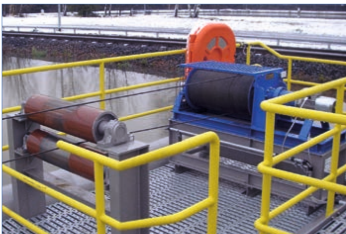
SB-E 304 als Traversierwinde für Wasseraufbereitungsanlage
